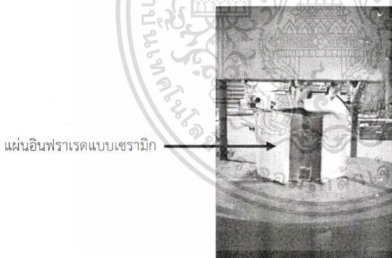
รูปที่ 3.13 การติดตั้งแผ่นอินฟราเรดแบบเซรามิก
