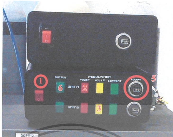
รูปที่ 3.18 ภาพแสดงลำดับการเปิดเครื่องจ่ายไฟให้กับห้องเคลือบสุญญากาศ
