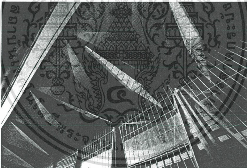
ภาพที่ 6.2 ตัวอย่างโครงสร้างแบบพับจีบ ผสมกับการใช้โครงถัก
