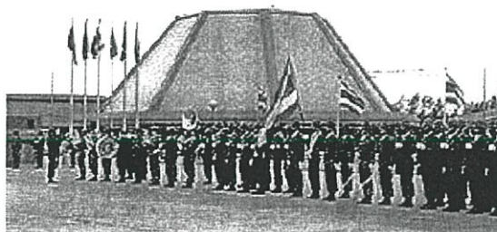
รูปที่ 3.40 แสดงการตั้งแถวรับเสด็จของทหารหน้าอาคารปริทัศน์
