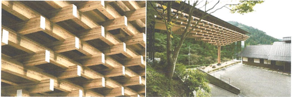
รูปที่ 3-34 ระบบชั้นส่วนประกอบของงานไม้ประยุกต์ประเพณีญี่ปุ่น
