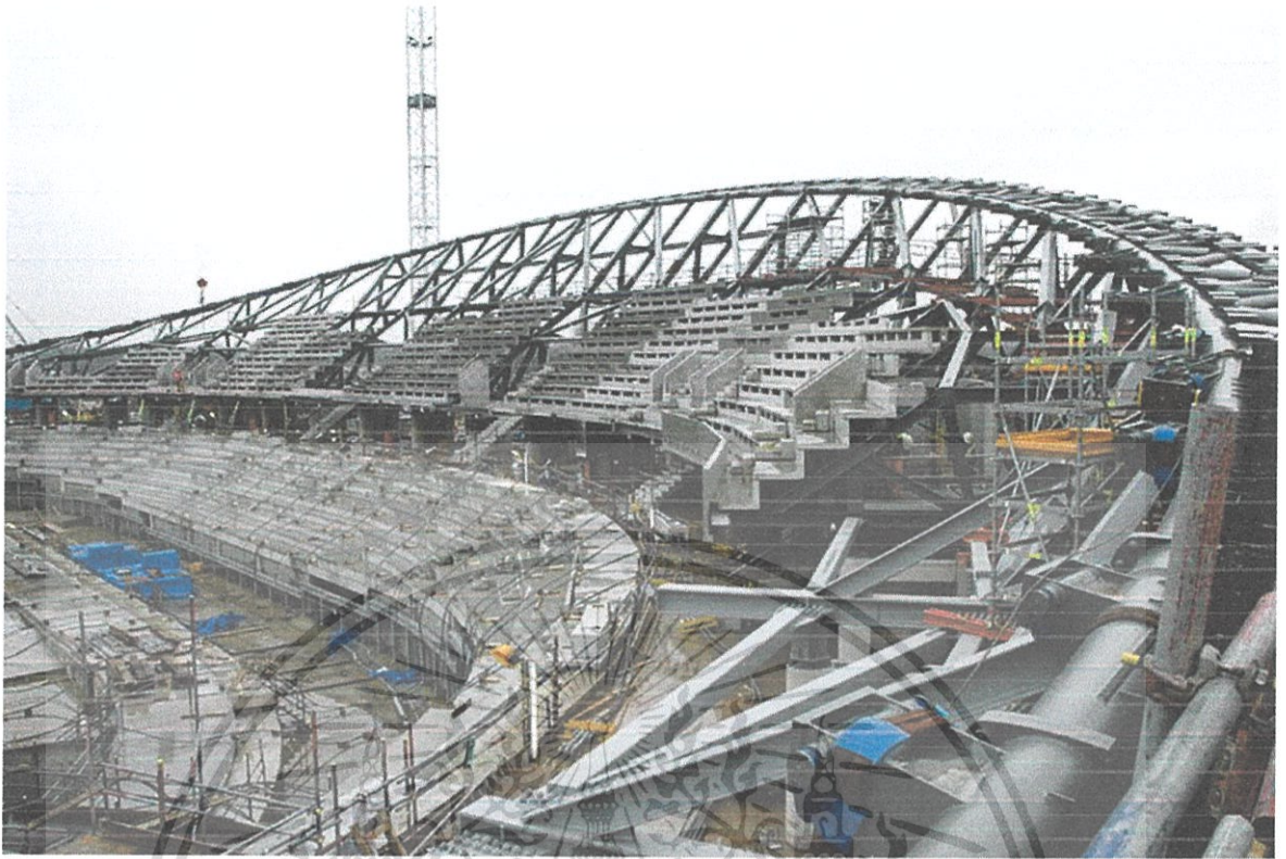
รูปที่ 3.11 แสดงภาพโครงสร้าง Space Truss
