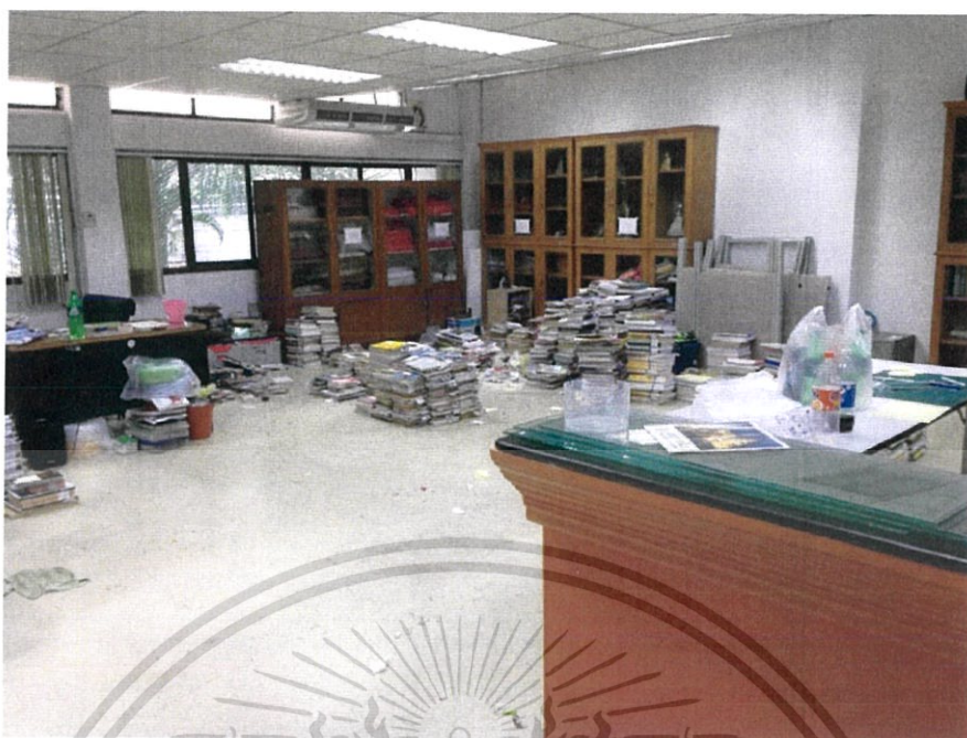
ภาพที่ 3.7 ห้องว่างชั้น 2 ของอาคาร ซึ่งกำลังปรับปรุงให้เป็นห้องสมุด
