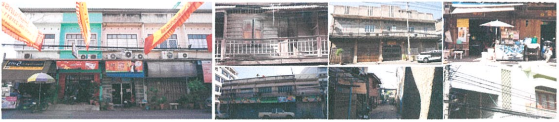
รูปที่ 7.4 ภาพแสดงรูปแบบอาคารในชุมชนปากน้ำโพ
