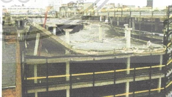
รูปที่ 2.9 แสดงการวิบัติของพื้นไครน
