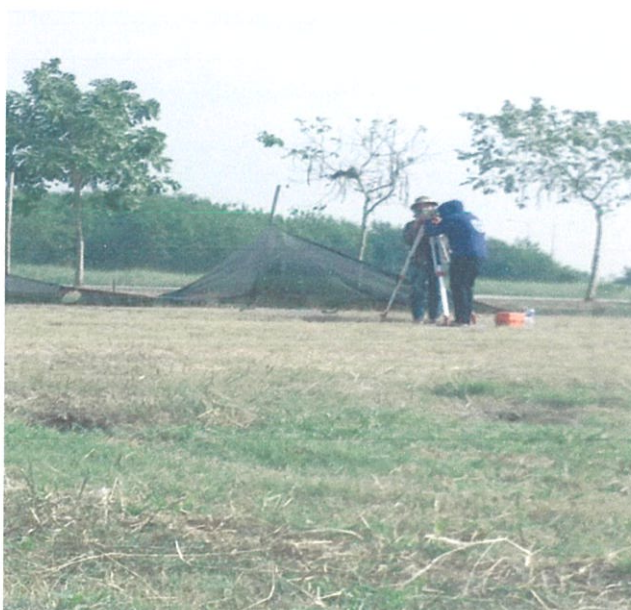
รูปที่ 3.19 การเก็บระดับปากท่อหลังกระบวนการทูลบอัดแบบไดนามิก
