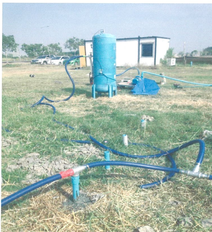
รูปที่ 3.17 กระบวนการดูน้ำด้วยระบบสุญญากาศ
