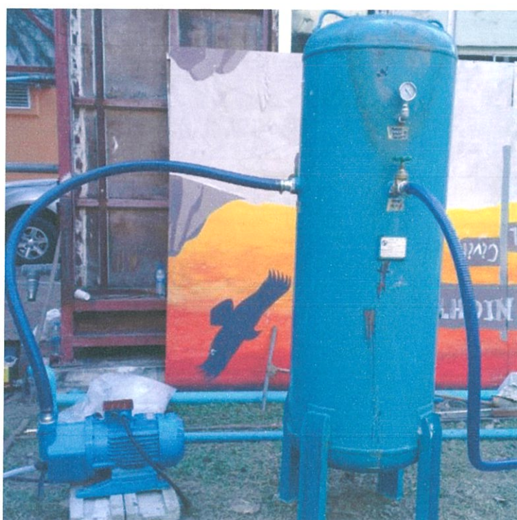
รูปที่ 3.10 การต่อเครื่องสูบน้ำสุญญากาศเข้ากับถังความดัน
