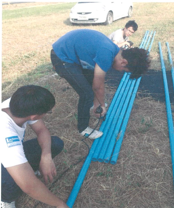
รูปที่ 3.4 ท่อระบายน้ำในแนวตั้งที่ดำเนินการเจาะรู
