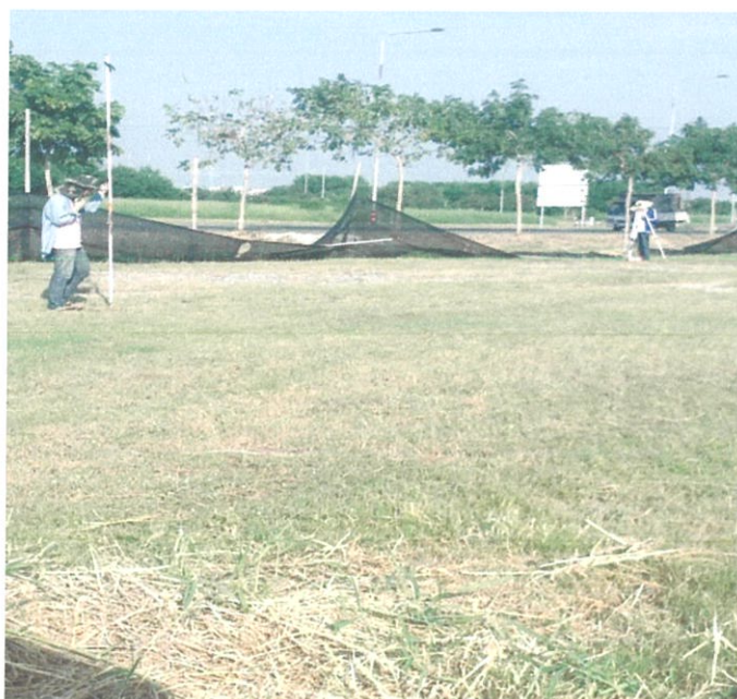
รูปที่ 3.16 การเก็บค่าระดับบริเวณปากท่อระบายน้ำในแนวตั้ง
