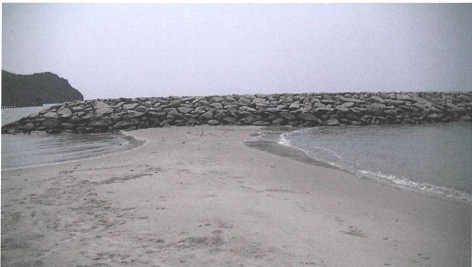
รูปที่ 4-25 ภาพถ่ายแสดงถึงการเกิดสันดอนเชื่อมเกาะ
