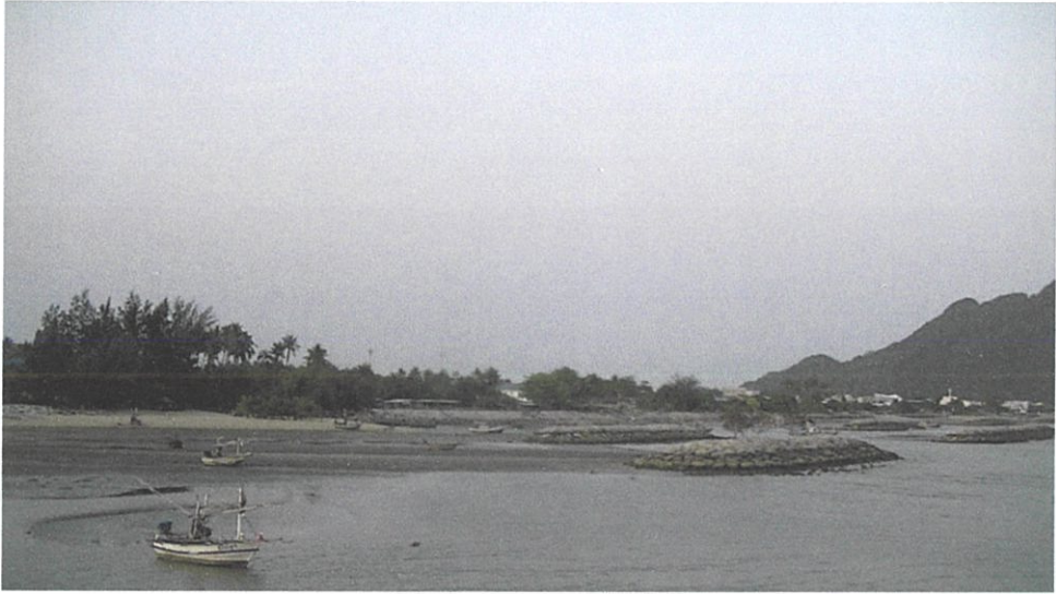
รูปที่ 4-32 ภาพถ่ายแสดงถึงการทับถมหลังเขื่อน
