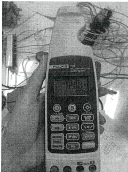
รูปที่ 3.10 จ่ายไฟจาก current injector ที่ 12 mA (50%)
