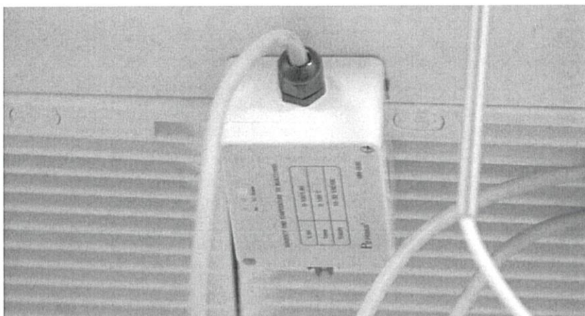
รูปที่ 7.2 แสดงการติดตั้งเซนเซอร์วัดอุณหภูมิและความชื้นสัมพัทธ์ HM 006 – Primus HM Series ณ ช่องลมกลับ
