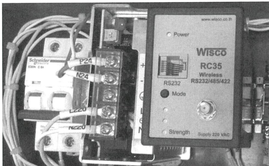
รูปที่ 7.6 แสดงการติดตั้งอุปกรณ์ Wireless RS-485 RC35-WISCO
