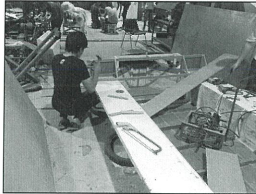
ภาพที่ จ.3.1 แสดงการสร้างแผงควบคุมเรือสะเทินน้ำสะเทินบก
