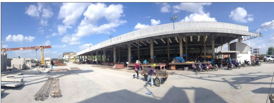
ภาพที่ 4.4 โรงงานผลิตผนังคอนกรีตสำเร็จรูป บจก.ซี-โพล ที่มา : ผู้วิจัย
