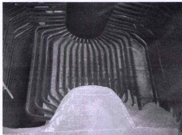
รูปที่ 3.4 ทางออกของไอเสียของหม้อน้ำ (อนุเคราะห์ภาพโดยบริษัท เพอร์โก อินดัสทรี จำกัด)
