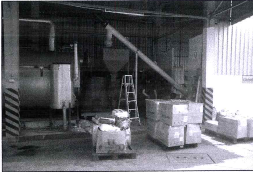
หม้อไอน้ำเชื้อเพลิงชีวมวล (หลังปรับปรุง)
