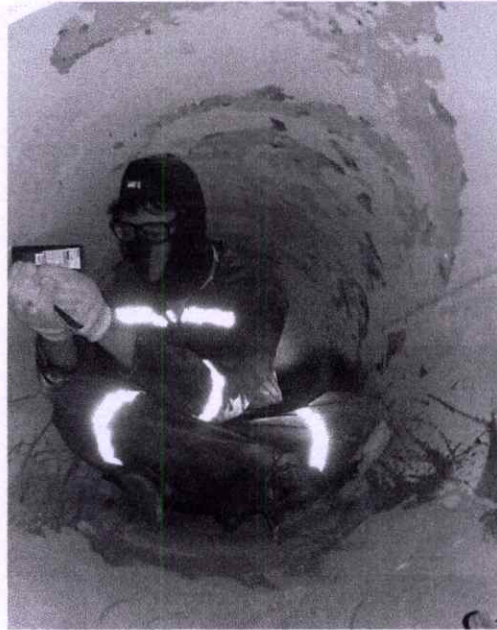
รูปที่ 3.6 การวัดเส้นผ่านศูนย์กลางในท่อไฟใหญ่
