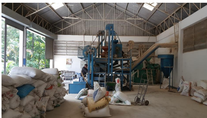
โรงสีข้าวของสหกรณ์การเกษตรพัฒนาเขาหินซ้อน จำกัด หมู่ 2 ตำบลเขาหินซ้อน อำเภอนมสารคาม จังหวัดฉะเชิงเทรา
