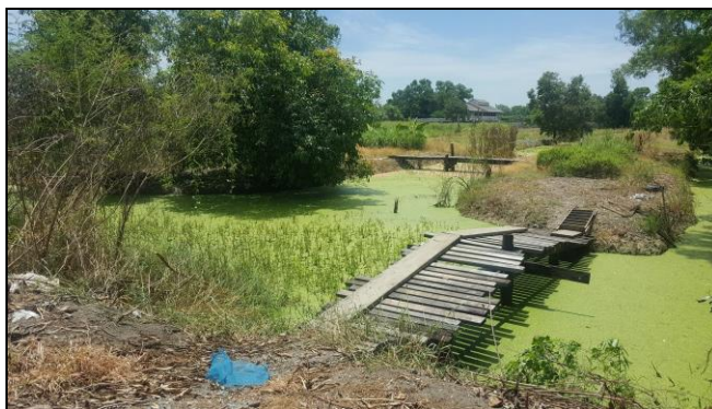
ภาพที่ 29 สะพานบริเวณทางเข้าที่ 2
