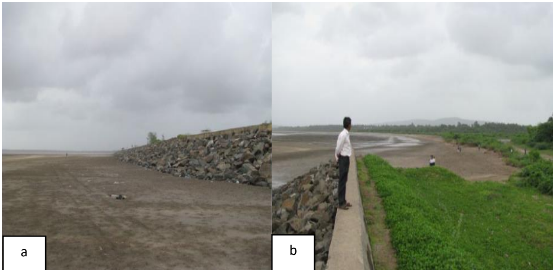
ภาพที่ 2.3 (a) ชายหาดที่มีก่อสร้างกำแพงกันคลื่นบริเวณชายฝั่ง Fansa ประเทศอินเดีย (b) บริเวณด้านข้างที่เกิด End wall effect
