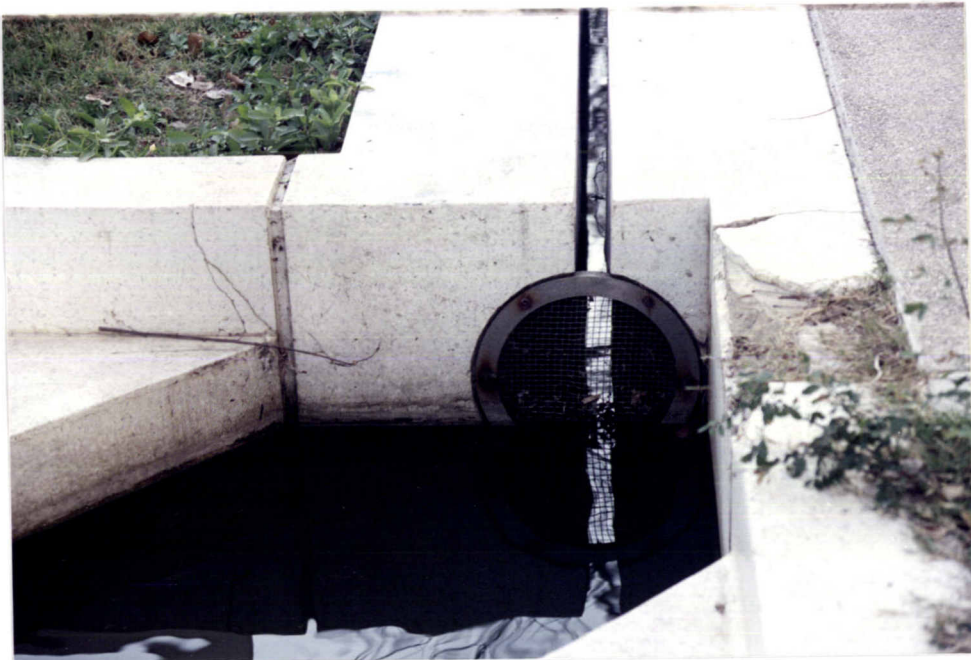
รูปที่ 3.14 การระบายน้ำจากสระน้ำออกสู่น้ำสาธารณะ
