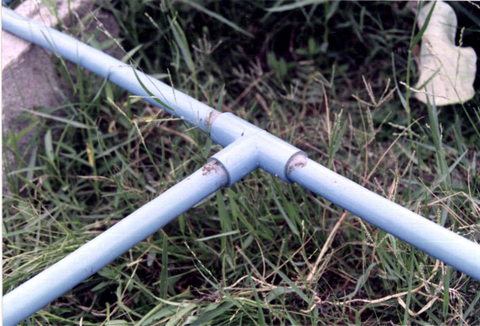
ภาพที่ 7 แสดงลักษณะการเชื่อมกันระหว่างท่อจ่ายน้ำและท่อประธาน
