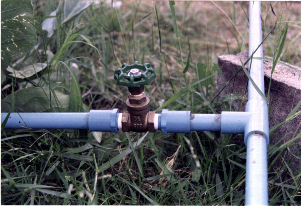
ภาพที่ 9 แสดงลักษณะการต่อท่อแขนงกับท่อประธานโดยมีประตุน้ำเชื่อม
