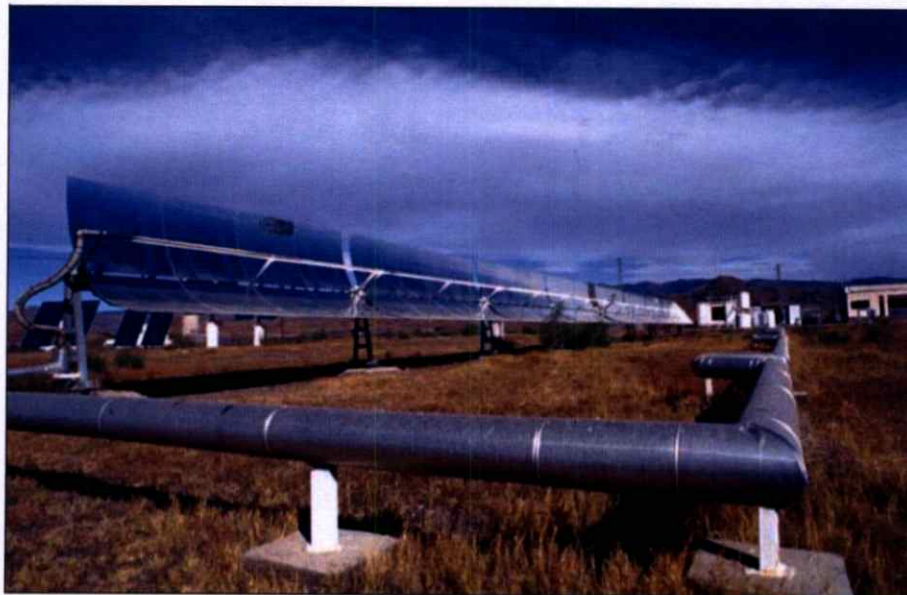
ภาพที่ 2.5 ตัวรวบรวมแสงตามแนวพาราโบลิก (Parabolic Trough Collectors) [7]
