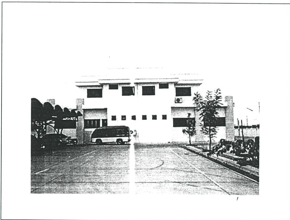
ภาพที่ 2.29 แสดงบริเวณด้านหลัง และที่จอดรถ
