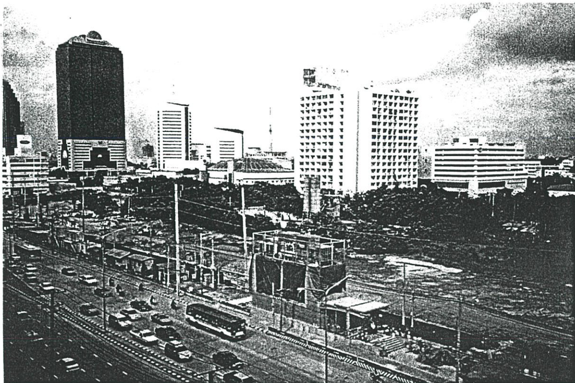
สถานีรถไฟฟ้า ถนนรัชดาภิเษกที่กำลังก่อสร้างและมีกำหนดดำเนินการเปิดเส้นทาง ปี พ.ศ.2546 นี้ ภาพที่ 2.23 สถานีรถไฟฟ้า ถนนรัชดาภิเษก
