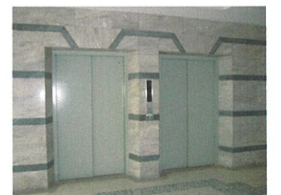
ลิฟท์ภายในอาคาร
