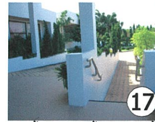
17 ทางเข้าอาคารศูนย์ผู้สูงอายุภาคใต้
