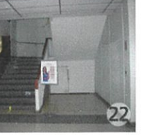
บันไดภายในอุบัติเหตุ
