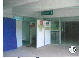
ห้องน้ำชายชั้น 1
