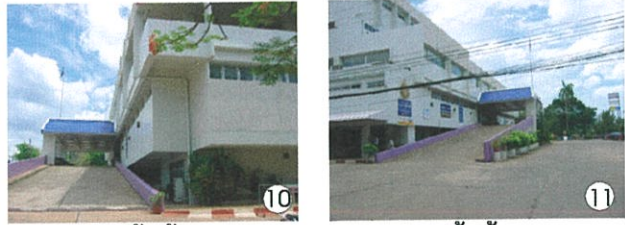
RAMP ทางขึ้นชั้น 2
