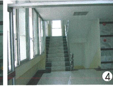
บันไดภายในอาคารจากอาคารผู้ป่วยใน
