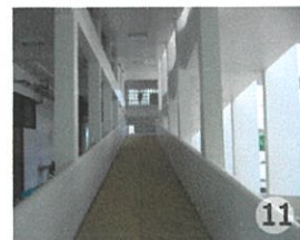
ทางลาดภายใน OPD
