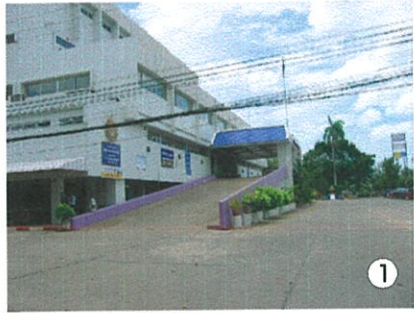
RAMP ทางขึ้นชั้น 2
