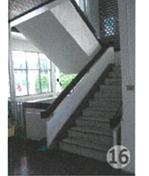
บันไดภายในอุบัติเหตุเก่า
