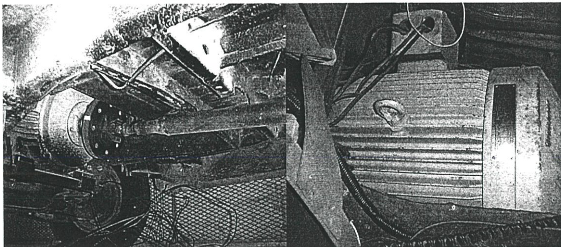
รูปที่ 3.10 ลักษณะติดตั้งมอเตอร์
