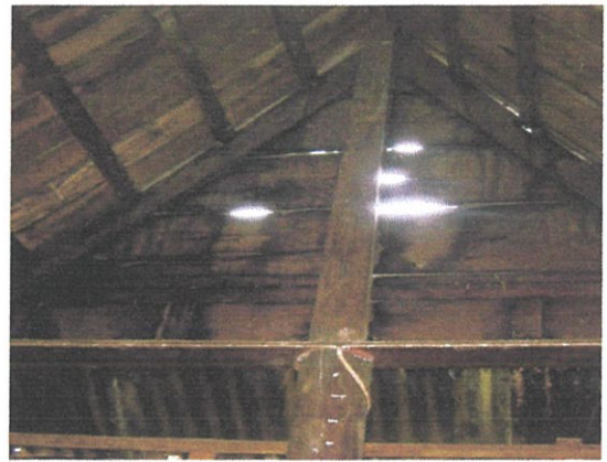
ส่วนของหลังคาภายใน
