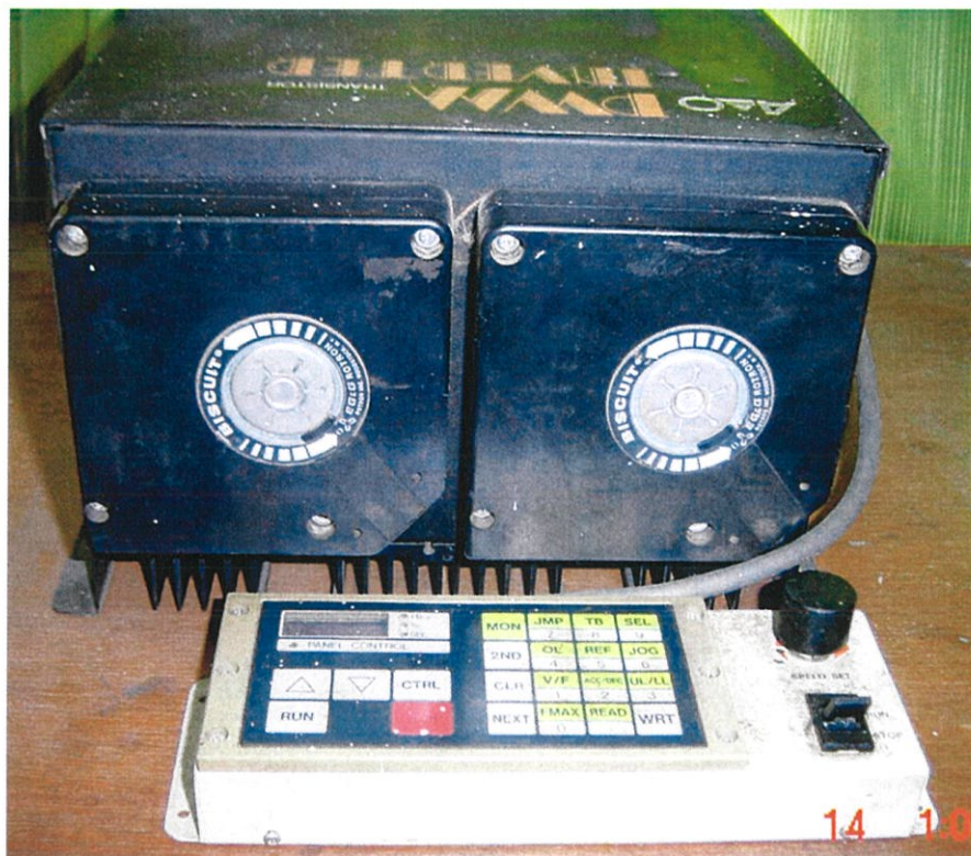
รูปที่ 6.6 แสดงอุปกรณ์ปรับเปลี่ยนความเร็วรอบของมอเตอร์
