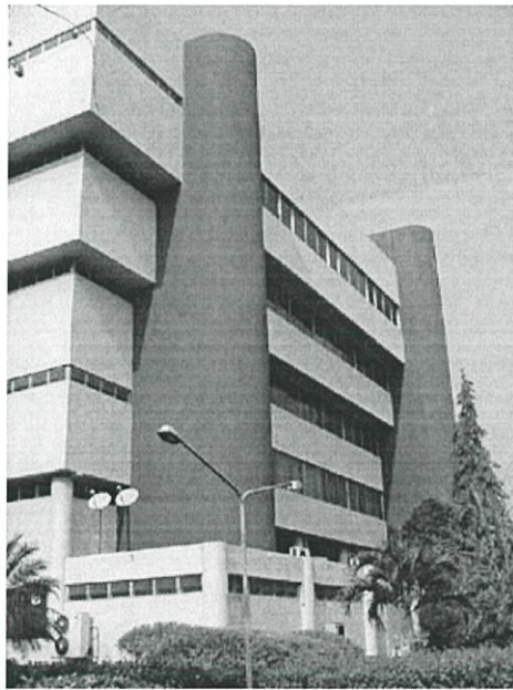
ผนังด้านทิศใต้ของอาคาร
