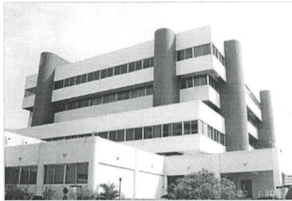
รูปที่ 3.3 แสดงผนังภายนอกและผนังทึบ ลักษณะ โครงสร้างของอาคาร
