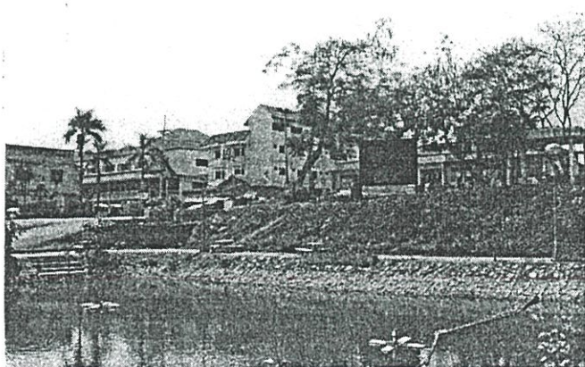
ภาพที่ 4.3 สภาพคูเมืองที่ขาดการดูแลเอาใจใส่ปัญหาน้ำเน่าเสียและต้นไม้แห้งแล้ง
