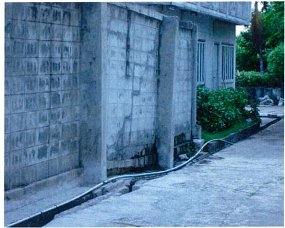
ภาพที่ 2.3 ภาพความเสียหายของสิ่งปลูกสร้างเนื่องจากการทรุดตัว
