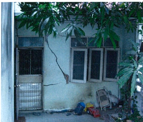
ภาพที่ 2.3 ภาพความเสียหายของสิ่งปลูกสร้างเนื่องจากการทรุดตัว
