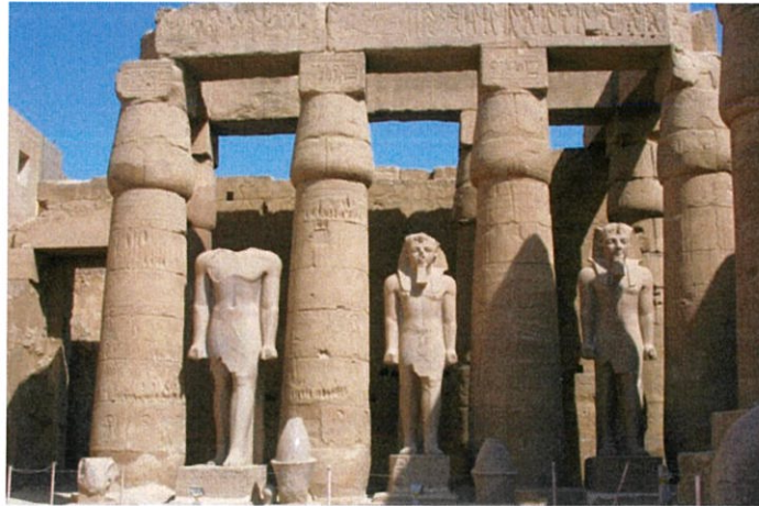
ภาพที่ 2.23 โครงสร้างเสาหินสำเร็จรูปในประเทศอียิปต์
