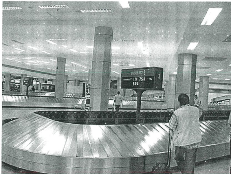
ภาพที่ 4.24 ระบบแจกจ่ายกระเป๋าสัมภาระแบบแผ่นชันทับ
