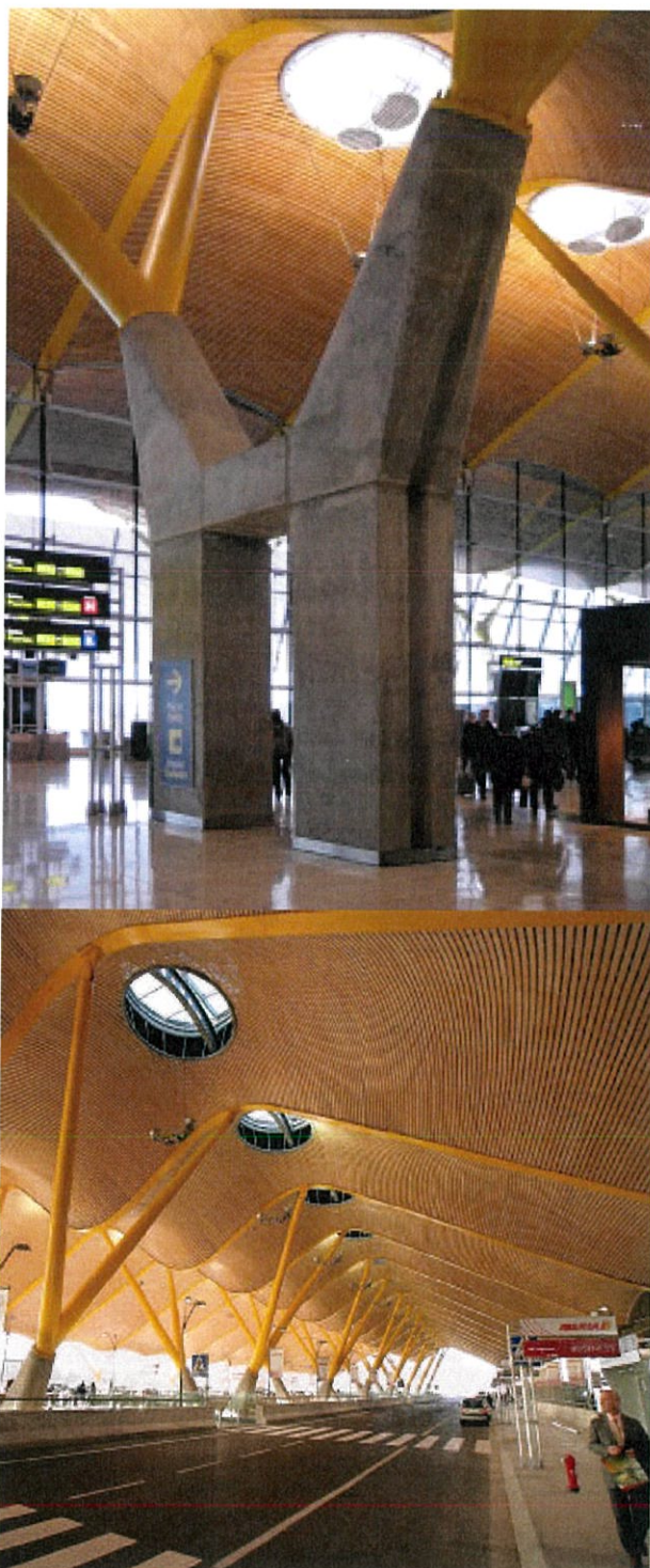
ภาพที่ 6.61 ภาพโครงสร้างเสาที่ใช้ภายในโครงการ
