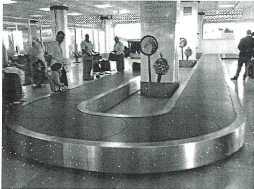
ภาพที่ 4.25 ระบบแจกจ่ายกระเป๋าสัมภาระแบบแผ่นเลื่อนเดี่ยวพระจันทร์
