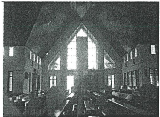
รูปที่ 4.34 แสดงสภาพปีกทั้ง 2 ข้างอาคาร
