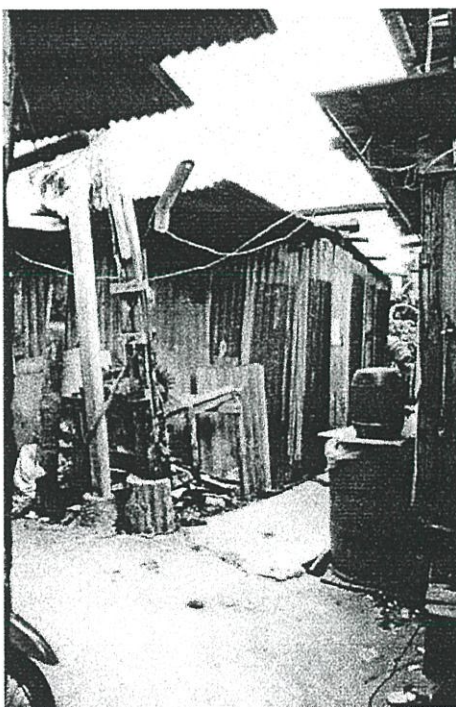
ภาพที่ 4.31 แสดงการติดตั้งเสาไฟฟ้าแสงสว่างในชุมชน ซึ่งชาวบ้านร่วมมือกันจัดทำ แต่ในปัจจุบันไม่สามารถใช้ได้แล้ว เพราะชุมชนไม่มีเงินเสียค่าไฟ
