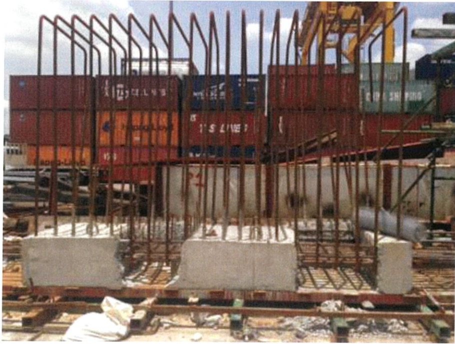
ภาพที่ ก.9 แสดงชิ้นส่วนคานคอนกรีตสำเร็จรูป 1 ชั้นส่วน (1)
