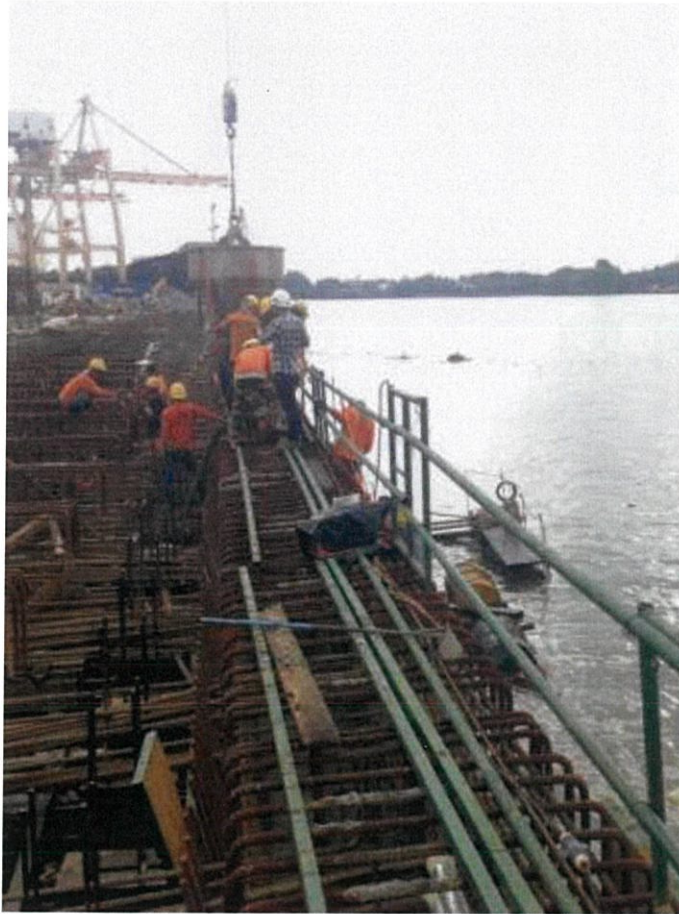
ภาพที่ ก.3 แสดงขั้นตอนการเทคอนกรีตในที่ คาน GB3
