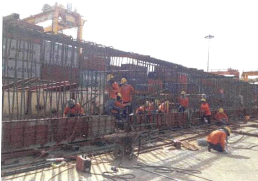
ภาพที่ ก.5 แสดงขั้นตอนการผูกเหล็กชั้นส่วนคานคอนกรีตสำเร็จรูป
