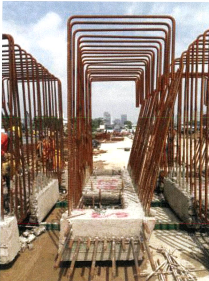
ภาพที่ ก.10 แสดงชิ้นส่วนคานคอนกรีตสำเร็จรูป 1 ชั้นส่วน (2)
