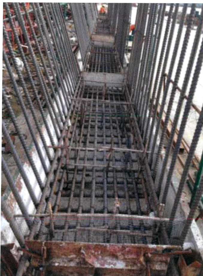
ภาพที่ ก.6 แสดงขั้นตอนการ Block-out ตำแหน่งหัวเสาเข็ม ชั้นส่วนคานคอนกรีตสำเร็จรูป
