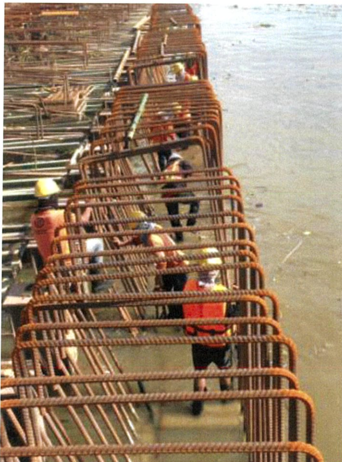
ภาพที่ ก.12 แสดงขั้นตอนการผูกเหล็กหลังติดตั้งชิ้นส่วนคานคอนกรีตสำเร็จรูป
