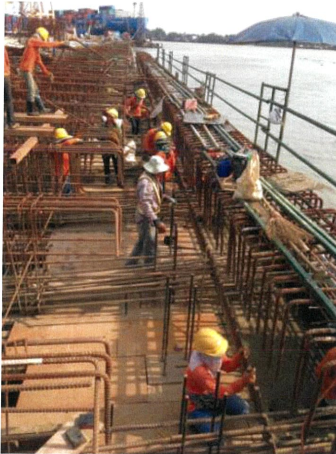
ภาพที่ ก.1 แสดงขั้นตอนการเข้าแบบหล่อคอนกรีตในที่ คาน GB3
