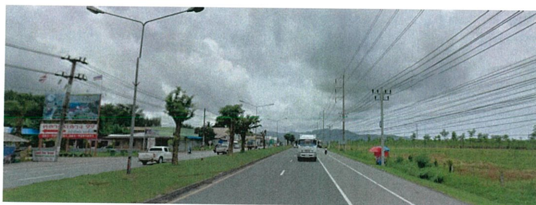
ภาพที่ 6.18 ทักษณียภาพบริเวณถนนด้านหน้าโครงการ
