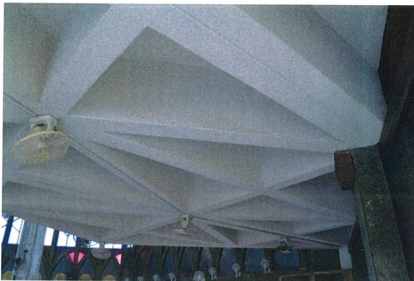
ภาพที่ 3.32 แสดง โครงสร้างพื้นแบบ waffle slab
