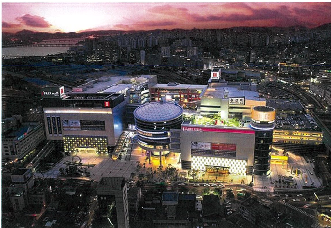
รูปที่ 3-39 แสดงอาคารไอ พาร์ค มอล
