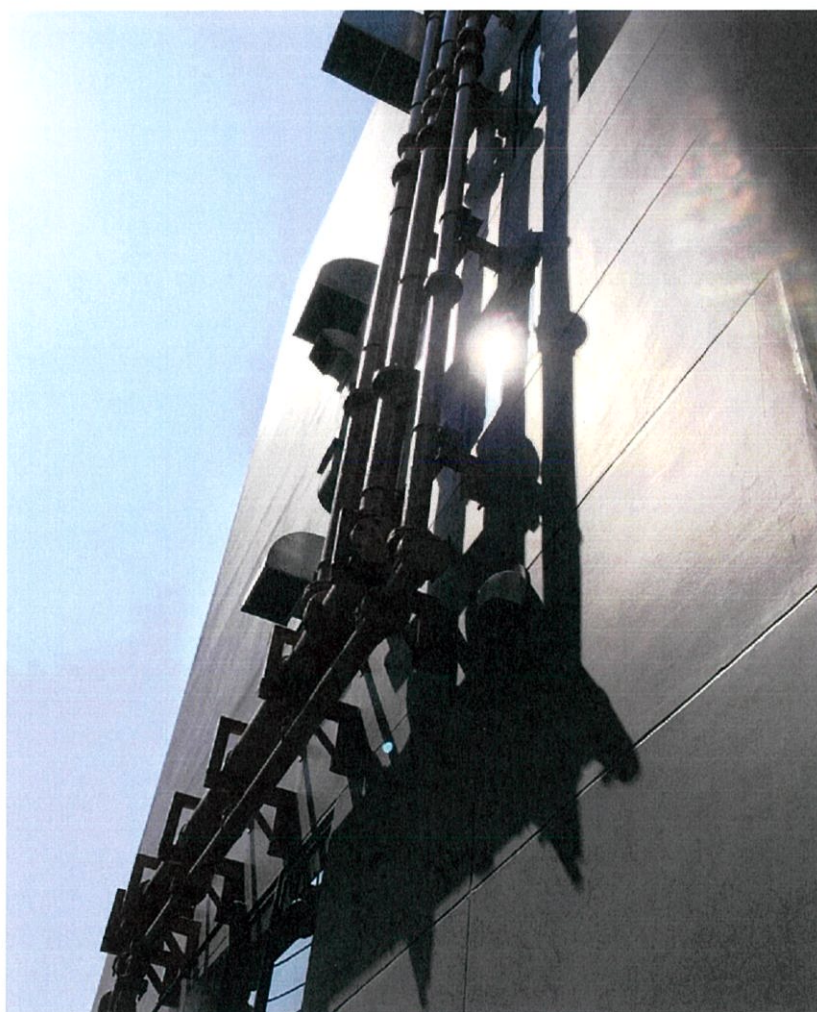
รูปที่ 3-21 แสดง ท่อเก็บน้ำฝน (21 มีนาคม 2558)
