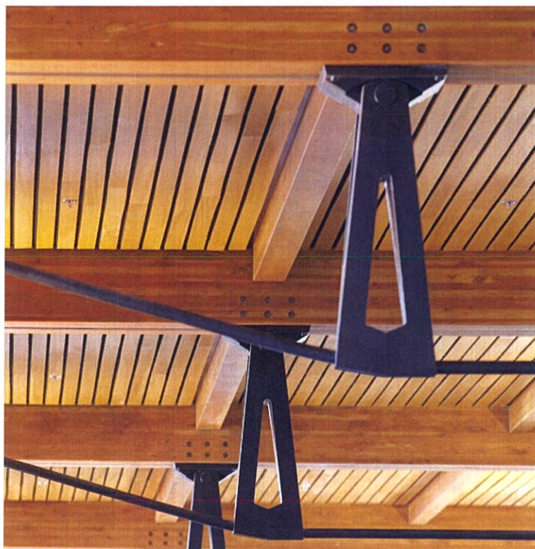
ภาพที่3- 29 รอยต่อโครงสร้างของอาคารผู้โดยสาร JACKSON HOLE AIRPORT ที่มา: http://www.designboom.com/architecture/gensler-jackson-hole-airport-04-09-2014/gallery/image/gensler-jackson-hole-airport-4/ (สืบค้นเมื่อ 29 พฤศจิกายน 2559)
