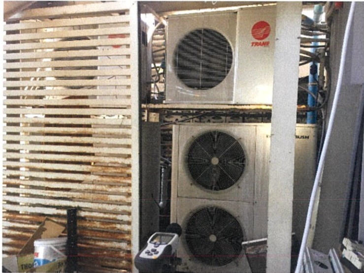
รูปภาพที่ 3.29 รูปการณ์วัดค่า Air compressor
