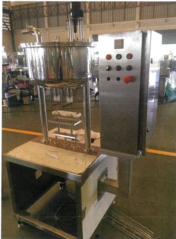
รูปที่ 3.26 เครื่องจักรเมื่อนำตู้ Control มาติดตั้งที่ตู้
