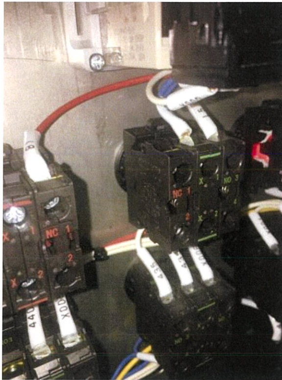
รูปที่ 3.24 สวิตช์ตอนเดินสายเสร็จเรียบร้อยแล้ว
