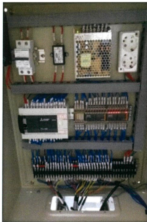
รูปที่ 4.6 อุปกรณ์ภายในตู้ที่ Wiring แล้ว
