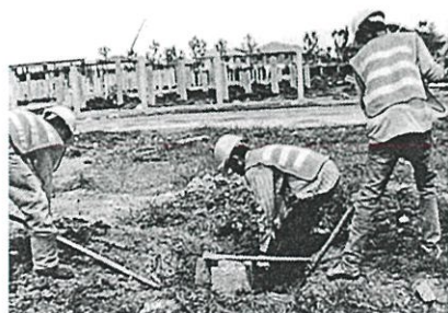
รูปที่ 4.4 ขุดดินเพื่อวางแบบ
