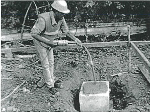
รูปที่ 4.12 จี้คอนกรีตใน Footing
