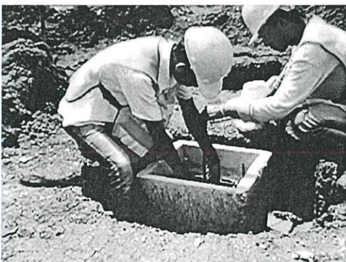
รูปที่ 4.10 วางคอก Footing
