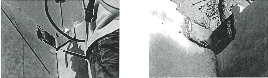
รูปที่ 4.24 ทำการประสานชิ้นงาน Precast ผนังชั้น 1 กับ ชิ้นงาน Precast ผนังชั้น 1 ด้วยการเชื่อม Plate ขนาด L75x75x75x6 mm.
