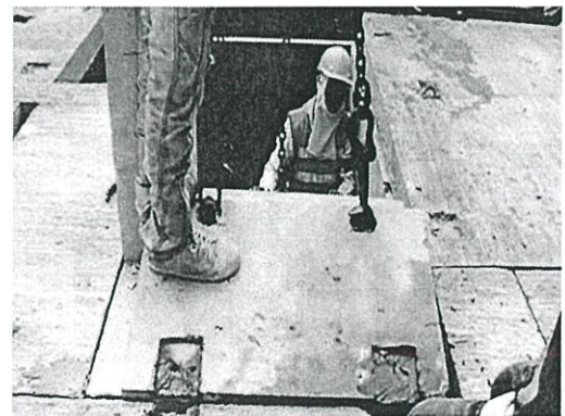
รูปที่ 4.33 ติดตั้งบันได
