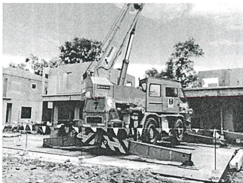
รูปที่ 3.18 การยื่นเครนและการกันเขตพื้นที่งานติดตั้ง
