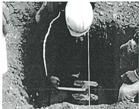
รูปที่ 4.9 ตรวจสอบ Pile deviate
