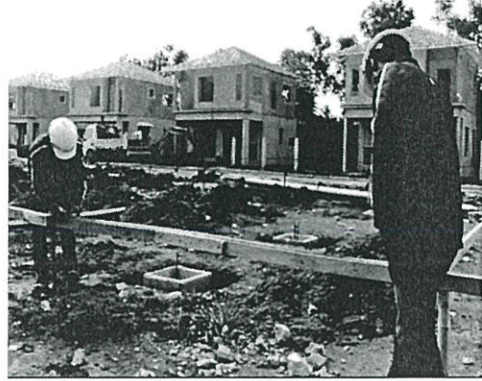
รูปที่ 4.7 ทำการตีฝั่ง Line Bar รอบบ้าน
