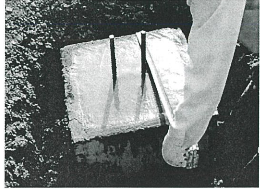
รูปที่ 4.13 ตรวจสอบตำแหน่ง Dowel
