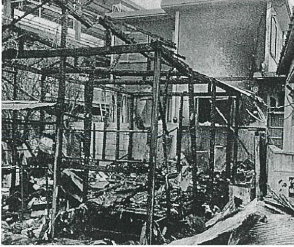
บ้านต้นเพลิงเป็นบ้านไม้ เกิดไหม้และ ลุลกลาม แต่ไม่สามารถผ่านบ้าน Precast ได้
