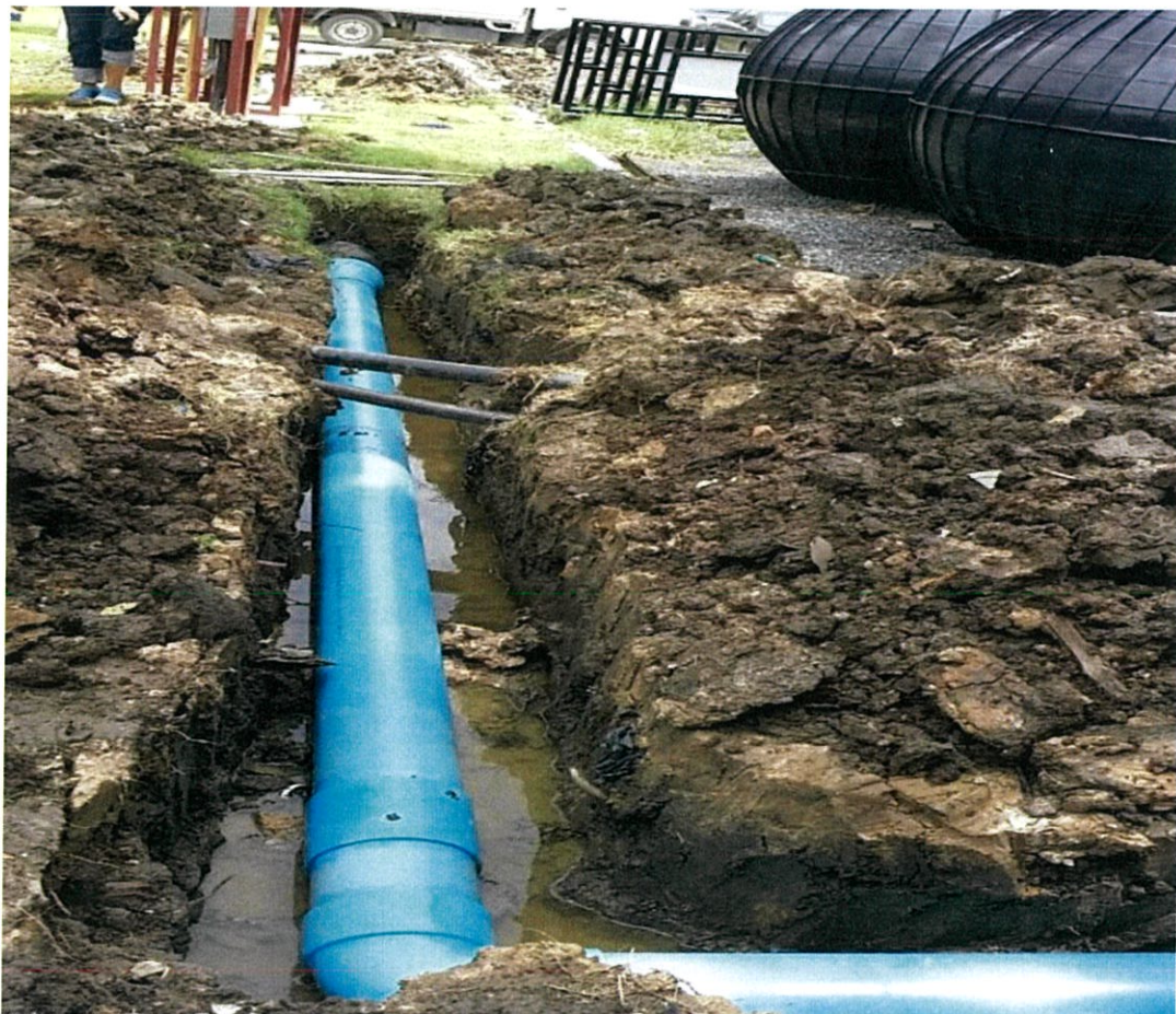
รูปที่ 4.5 ติดตั้งปั๊มบ่อสูบล้าง
