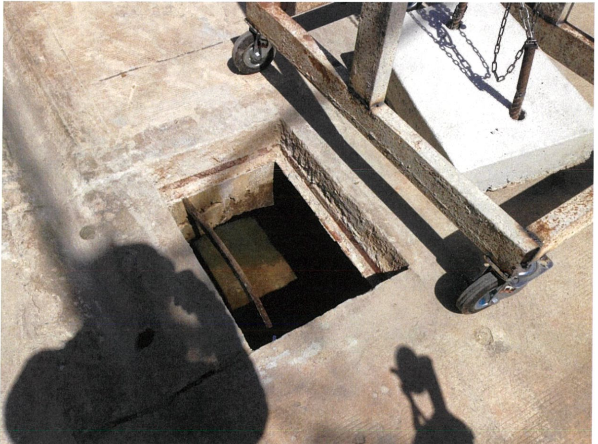
รูปที่ 4.3 เปิดฝาบ่อเพื่อเช็คระดับน้ำ
