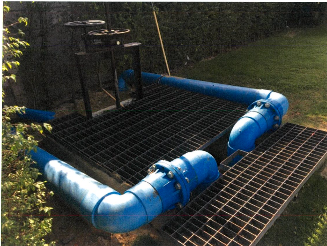
รูปที่ 4.7 บ่อตรวจที่ติดตั้งปั๊มและประตูน้ำ
