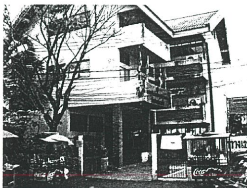
ภาพที่ 4.3 มุมมองของอาคารจากประตูทางเข้าออกห้องสมุดฯ วัดลาดปลาเค้า
