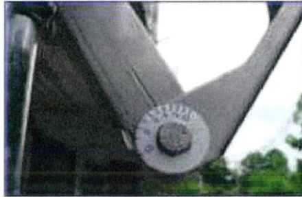
รูปที่ 2.23 การปรับเชิงกลหน้าสายอากาศ
