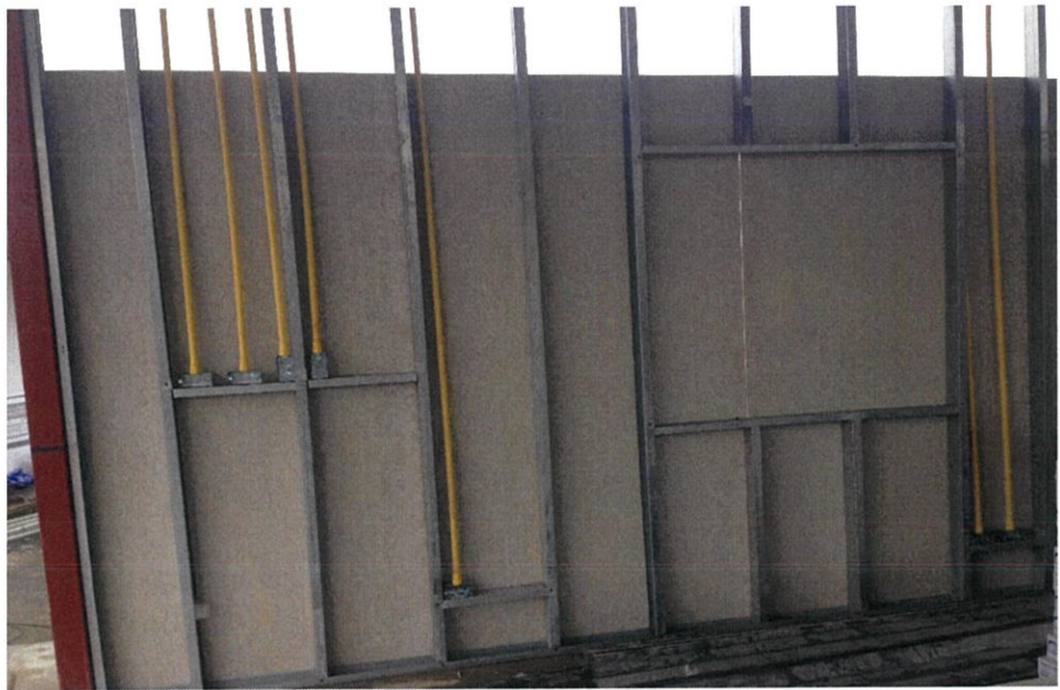
วางตำแหน่งปลั๊กไฟและเดินสายไฟ
