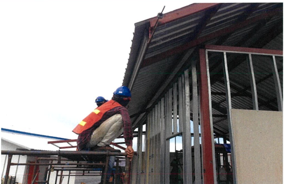
ติดตั้งกันสาดรอบอาคารกันฝนเข้าในอาคาร
