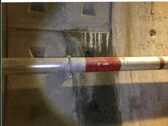
จุดที่ #03 Segment No. 460 ซึ่มีตามรอยต่อ
