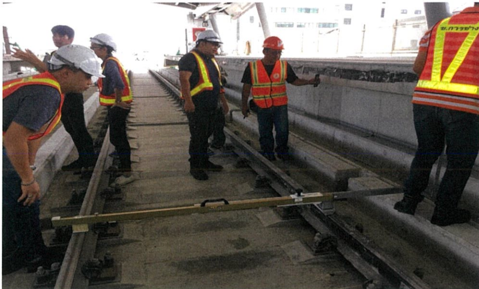
ภาพที่ 23 การใช้งานเครื่องมือวัดระยะห่างและความสูงของขานชลาทกับรางรถไฟ
