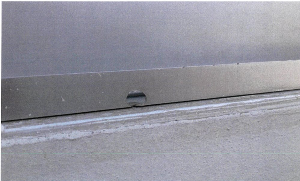
ภาพที่ 17 เจาะรูวงกบอะลูมิเนียมและยิงซิลิโคนรอบหน้าต่าง
