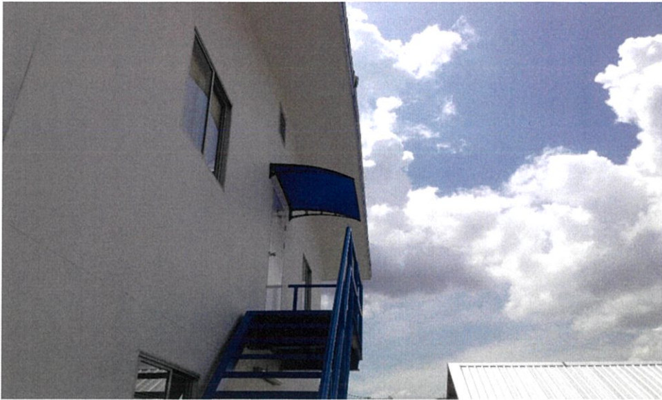
ภาพที่ 16 ติดตั้งกันสาดบริเวณประตูหนีไฟ
