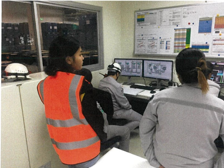
ภาพที่ 4.13 บรรยากาศการ Commissioning
