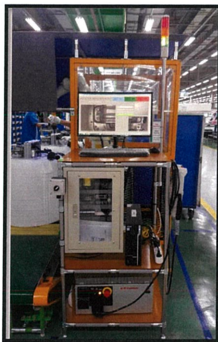
รูปที่ 4.4 ติดตั้งตู้ไฟและทดสอบการทำงาน
