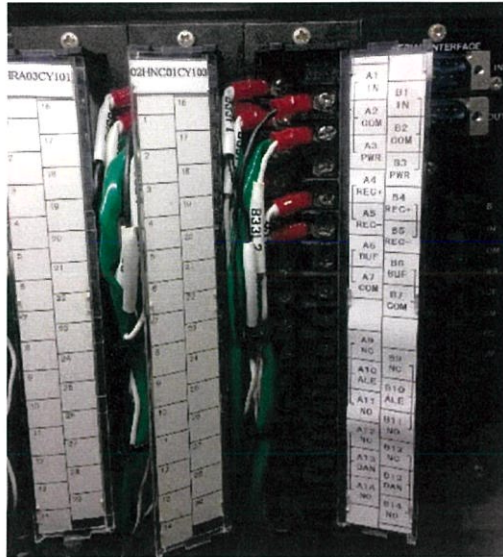
รูปที่ 3.27 สภาพสายหน้างานจริงของชุดอุปกรณ์การวัดแรงสั่นสะเทือน
