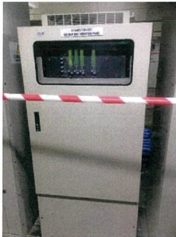
รูปที่ 3.20 ตู้ FAN BRG. VIBRATION
